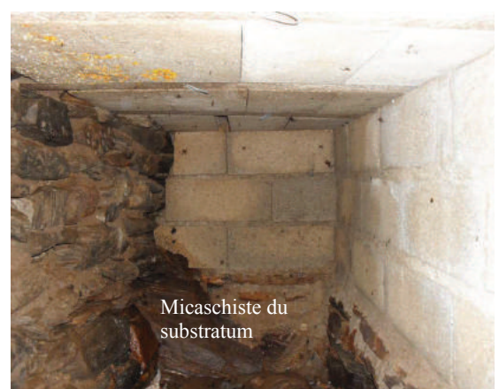
Planche photographique n°5 : vue de l'intérieur de la galerie drainante
