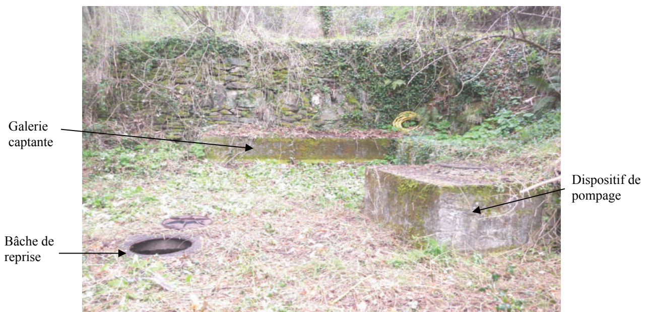
Planche photographique n°1 : vue du captage des PONCHETS
